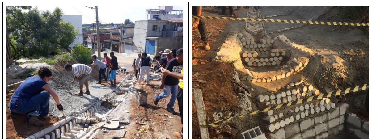
Figuras 12 e 13 - Construção da biovaleta realizada em sistema de mutirão pelos alunos e moradores do Jd. da União. Fonte: Acervo CPPATHIS, 2019.
